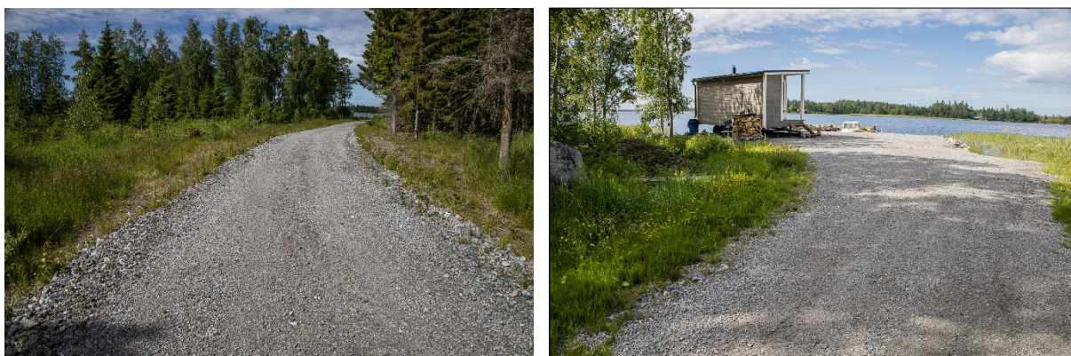
Bild 3 och 4. Väg är dragen ner till stranden och här har placerats en liten stuga på hjul samt färdigställt en båthamn.
