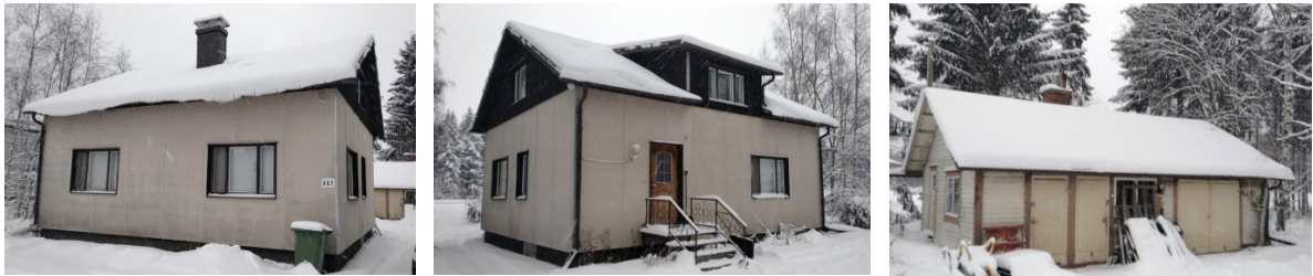
Kuva 7. Jälleenrakennusaikakauden pihapiiriin Eteläinen Luodontiellä 487 kuuluvat asuinrakennus vuodelta 1950 ja piharakennus. Vasemmanpuoleisessa kuvassa on julkisivu koilliseen tielle päin, keskellä näkymä lounaan ja vasemmalla piharakennus idän puolelta.
