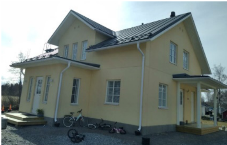
Bild 8. På Furuholmsgränden 7 finns en bostadsbyggnad byggd 2020.
