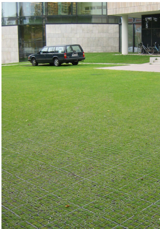
Figur 10. Principbild av genomtränglig beläggning.
