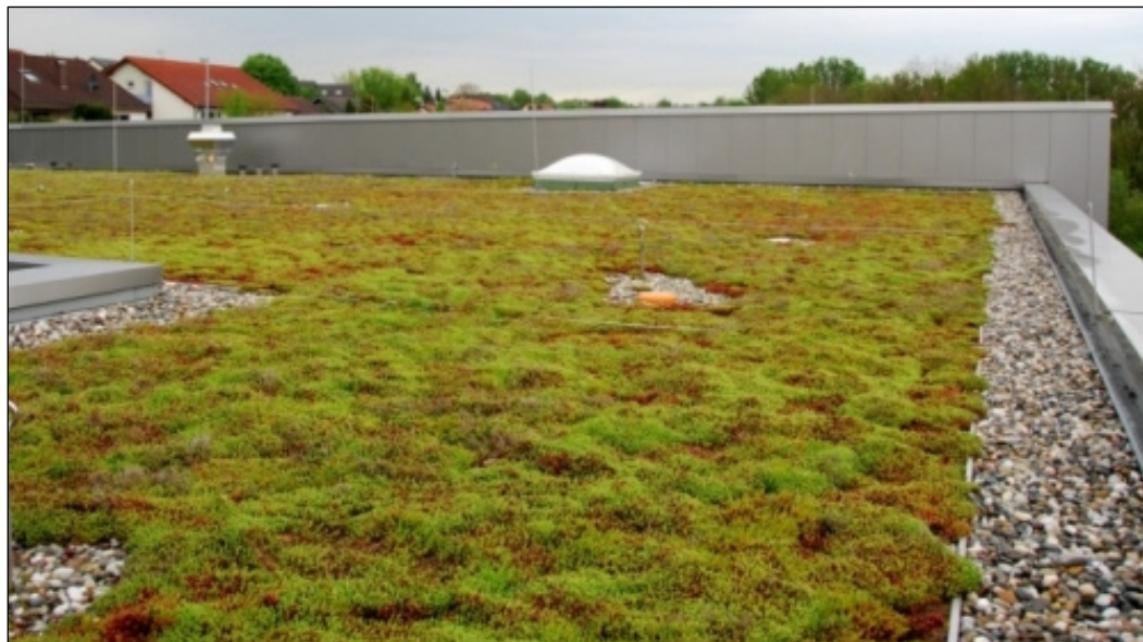
Figur 12. Exempel på ett lättskött sedumtak. Bild: Envire Oy.
