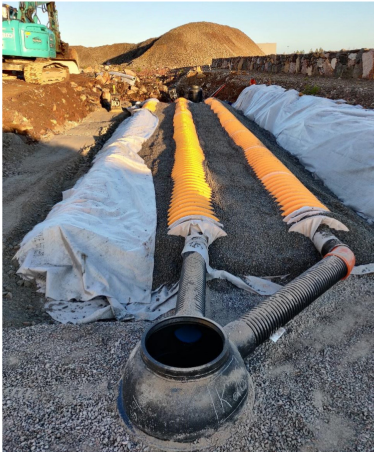
Figur 18. Principbild av dagvattentunnel. Bild: Viacon Oy.
