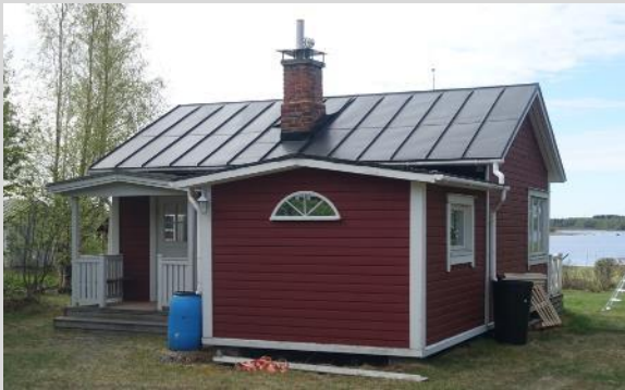
Fritidshus, fasad mot norr.
