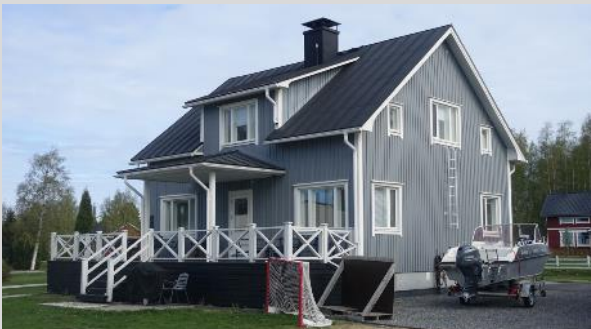
Bostadshus, fasad mot söder och öster.
