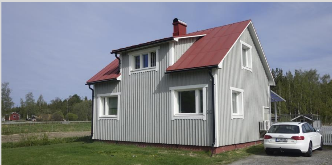
Bostadshus, fasad mot söder och öster.
