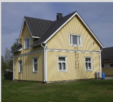
Fasader mot söder och öster.
