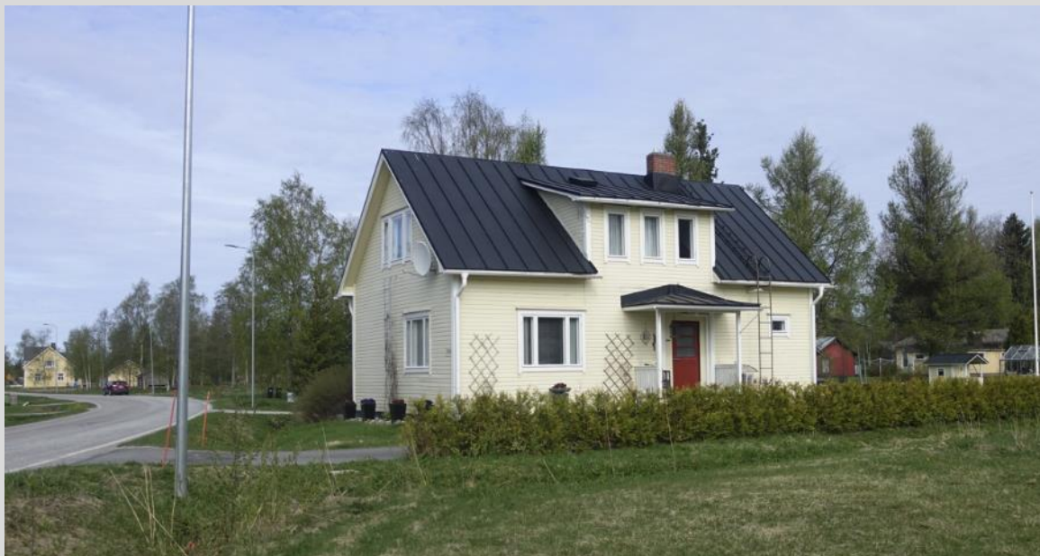
Bostadshus, fasad mot öster.
