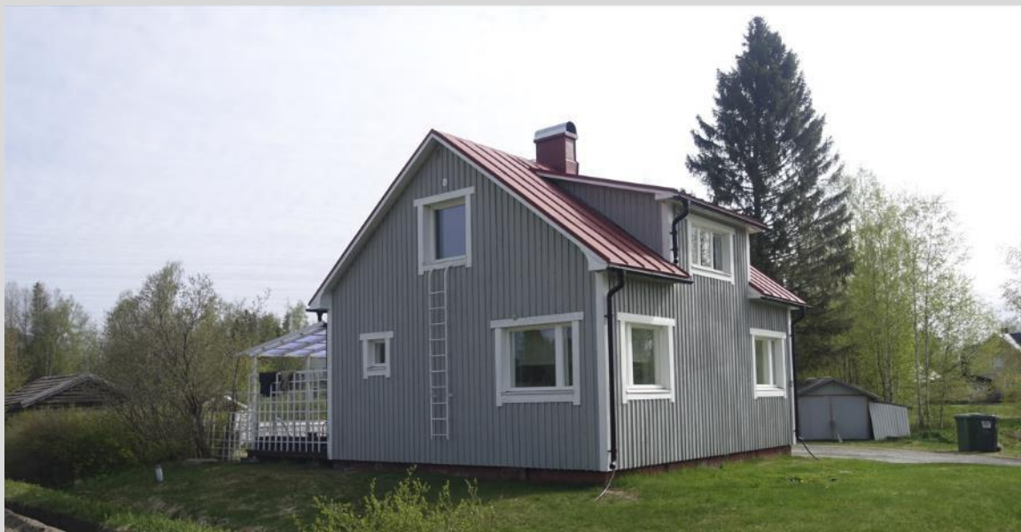
Bostadshus, fasad mot söder och väster.
