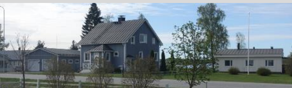
Bostadshus, fasad mot söder och norr.
