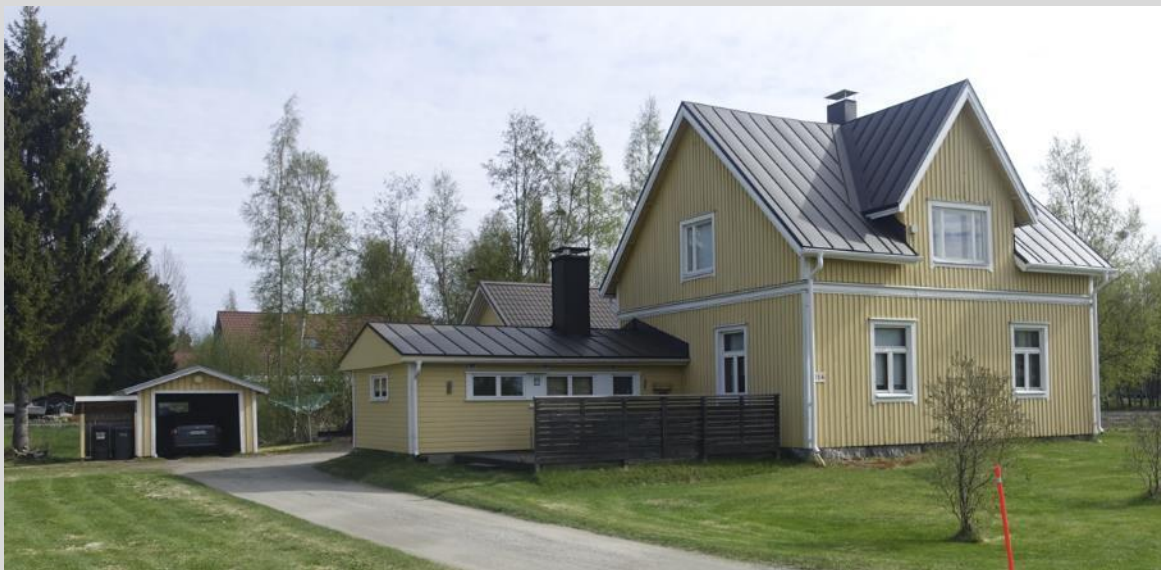
Bostadshus, fasad mot söder och väster.
