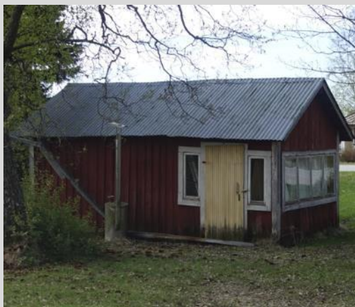
Uthus (1), fasader mot norr och väster.
