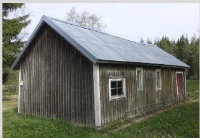
Uthus, fasader mot öster och söder.
