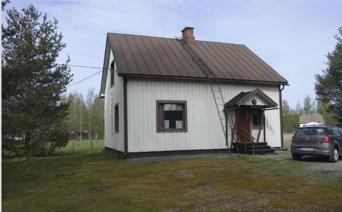
Bostadshus, fasad mot öster.
