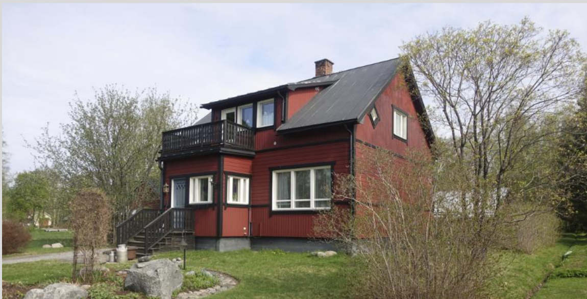
Bostadshus, fasad mot söder och öster.
