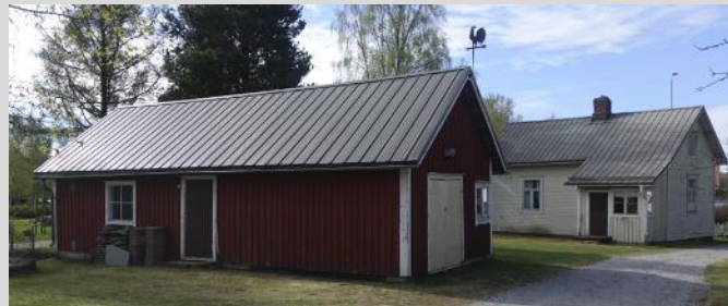
Bostadshus, fasader mot väster.
