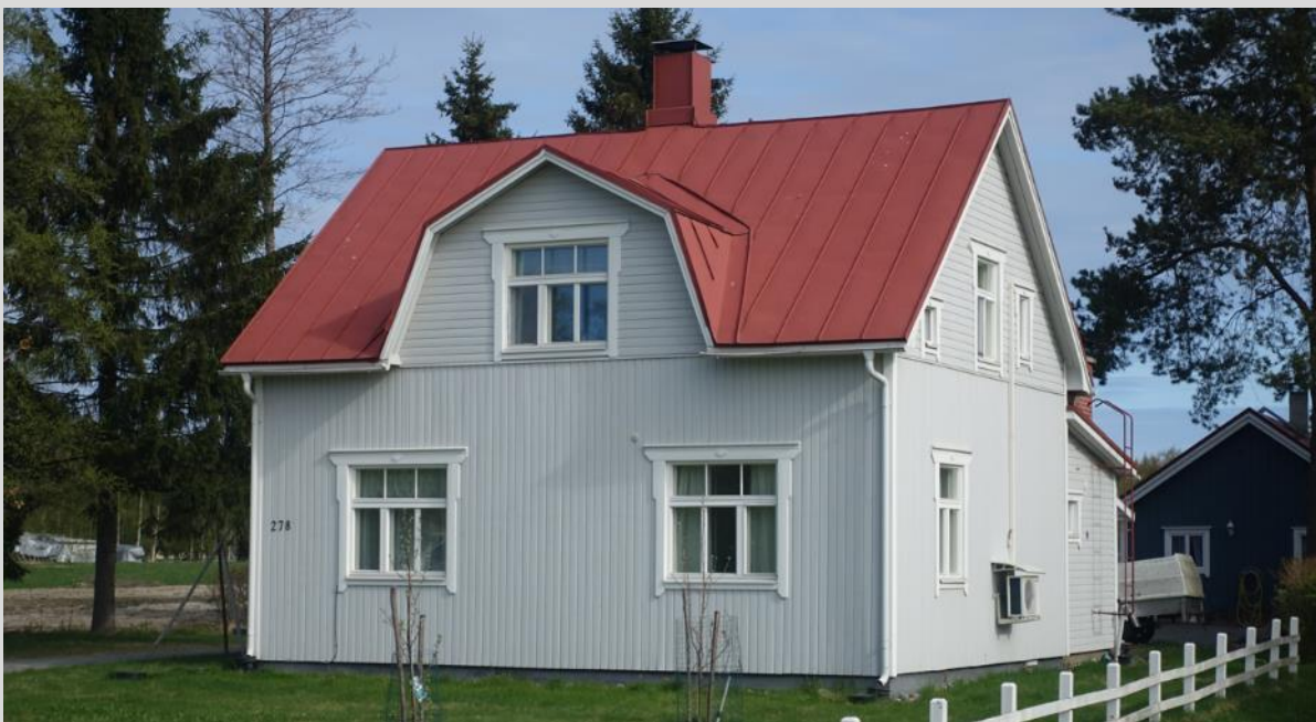
Bostadshus, fasad mot söder och öster.
