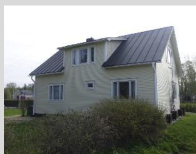
Bostadshus, fasader mot väster.
