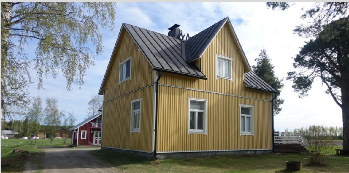
Bostadshus, fasader mot norr och väster.
