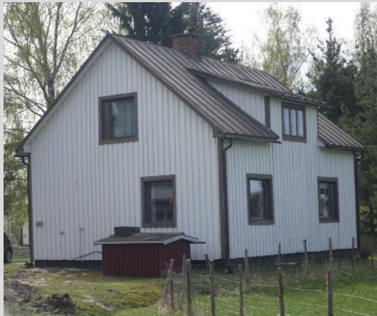
Bostadshus, fasad mot väster och norr.
