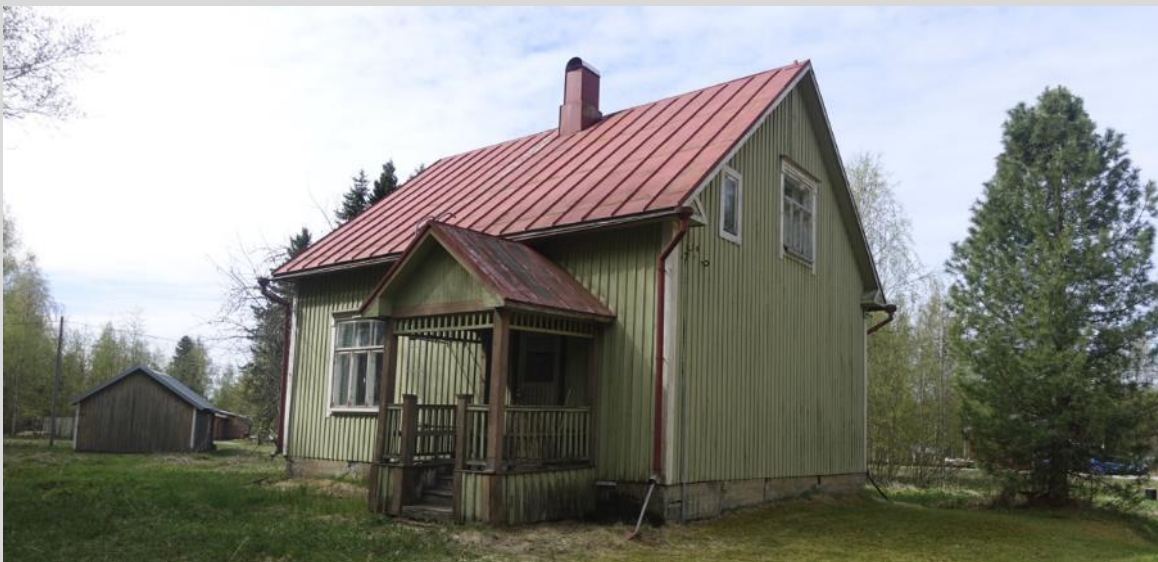
Bostadshus, fasader mot öster och norr.
