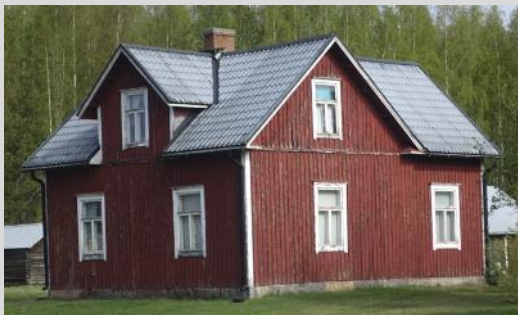
Bostadshus, fasad mot söder och öster.
