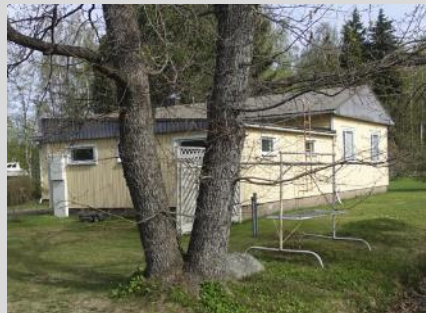
Fasader mot söder och öster.
