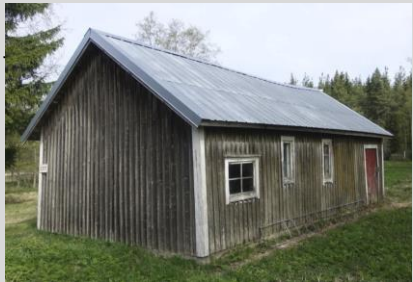
Ulkorakennus, julkisivut itä-etelä.
