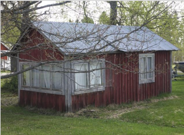
Ulkorakennus (1), julkisivut etelä-länsi.
