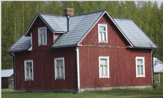
Asuinrakennus, julkisivu etelä-itä.
