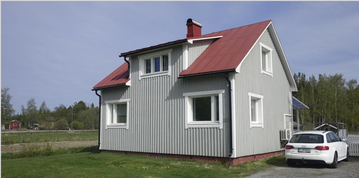
Asuinrakennus, etelä-itä julkisivu.
