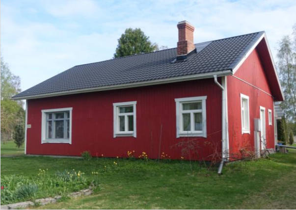
Asuinrakennus v. 1923, julkisivut etelä-itä.
