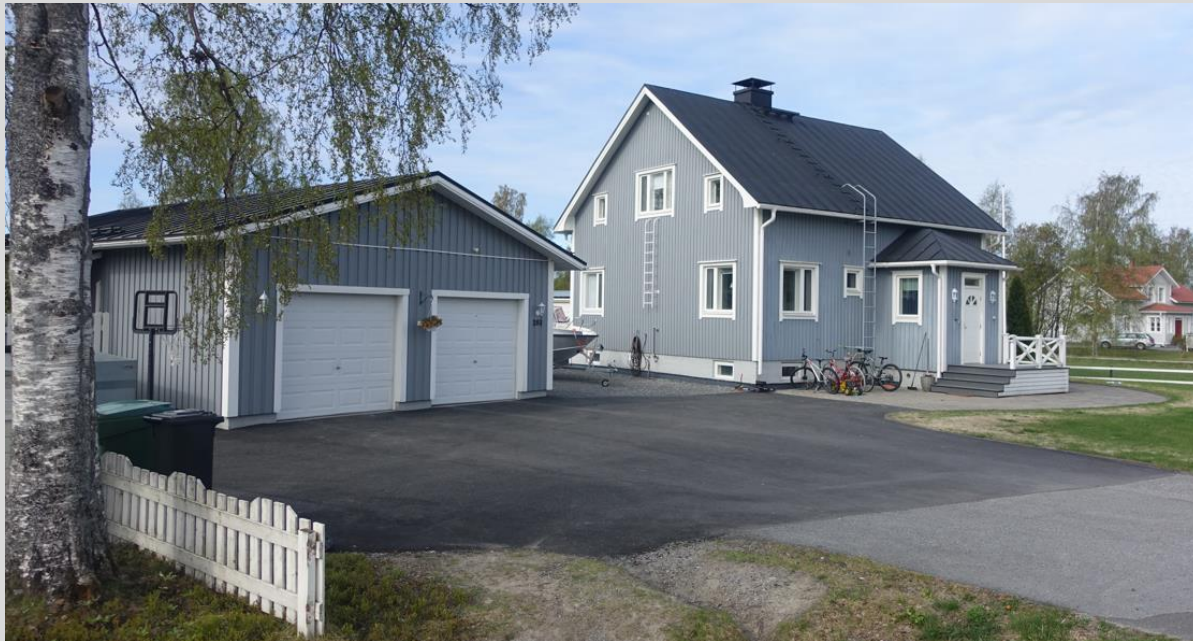
Asuinrakennus ja autotalli kuvattuna Risöhallintieltä etelään.
