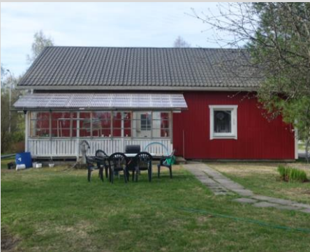
Asuinrakennus v. 1929, julkisivut pohjoinen.
