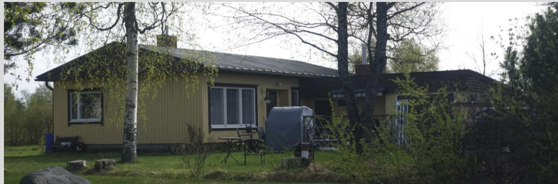
Asuinrakennus, länsi-etelä julkisivu.
