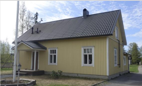
Asuinrakennus, pohjoinen julkisivu.
