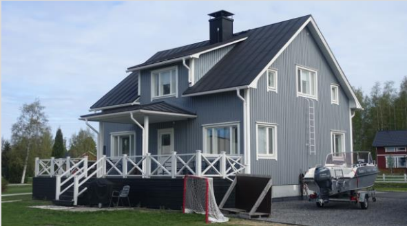
Asuinrakennus, julkisivu etel-itä.
