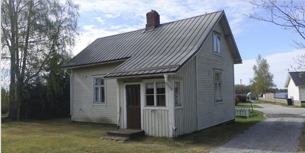
Asuinrakennus, pohjoinen julkisivu.
