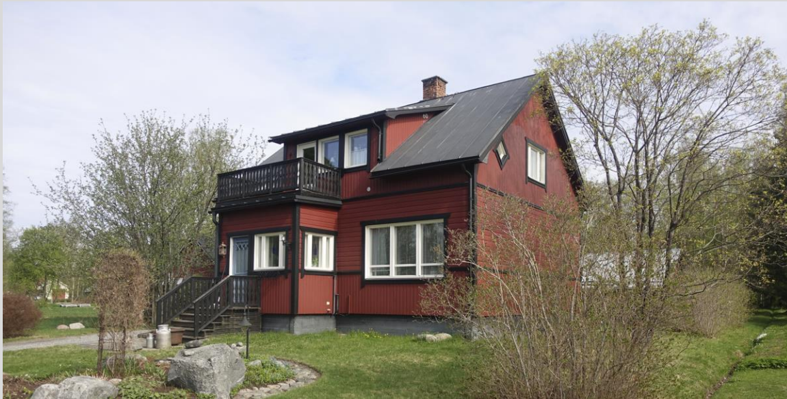
Asuinrakennus, julkisivu etelä-itä.
