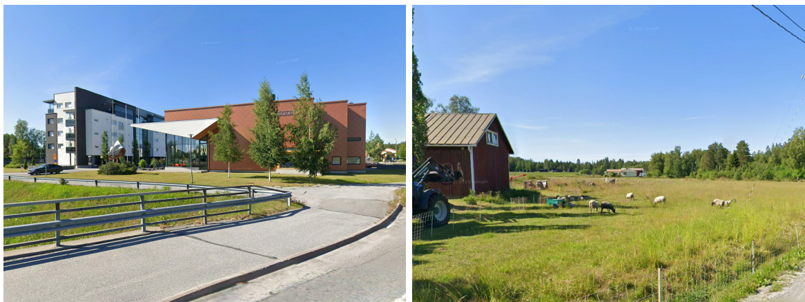
Bild 3. Till vänster, vy över Equityhuset i Holm centrumområde. Till höger, vy längs Strömsholmsvägen i Byggmäsar-Slussnäs, ett stenkast från centrumstrukturen. © Google Maps
