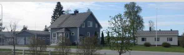
Bostadshus, fasad mot söder och norr.
