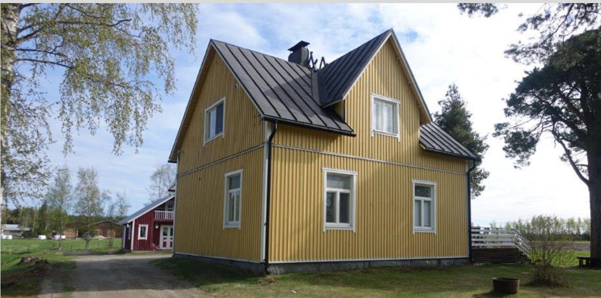
Bostadshus, fasader mot norr och väster.
