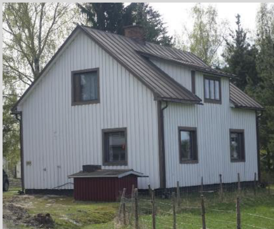
Bostadshus, fasad mot väster och norr.
