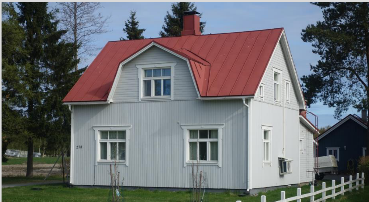
Bostadshus, fasad mot söder och öster.
