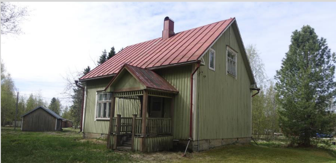
Bostadshus, fasader mot öster och norr.
