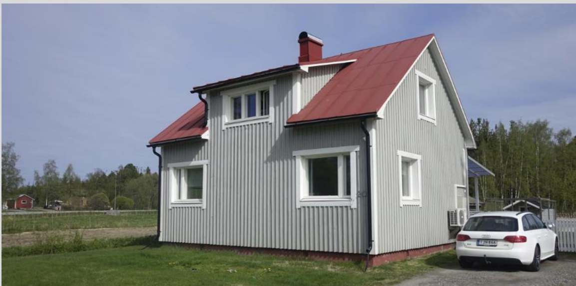
Bostadshus, fasad mot söder och öster.
