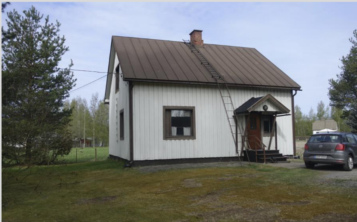
Bostadshus, fasad mot öster.
