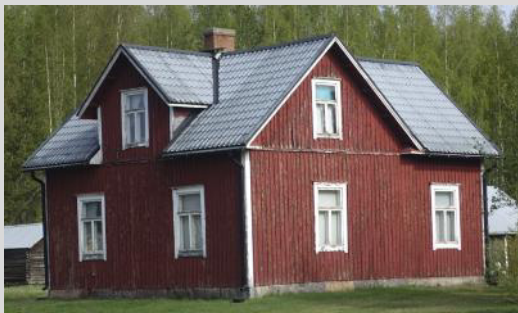
Bostadshus, fasad mot söder och öster.
