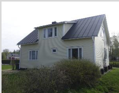
Bostadshus, fasader mot väster.
