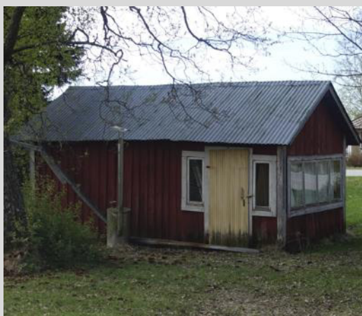
Uthus (1), fasader mot norr och väster.
