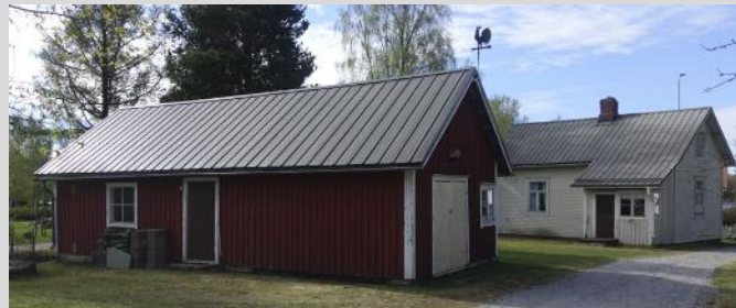
Bostadshus, fasader mot väster.
