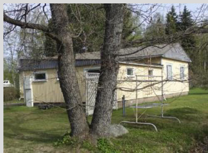
Fasader mot söder och öster.
