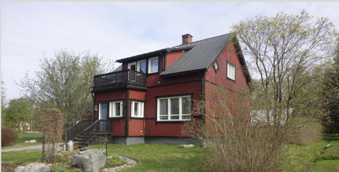
Bostadshus, fasad mot söder och öster.
