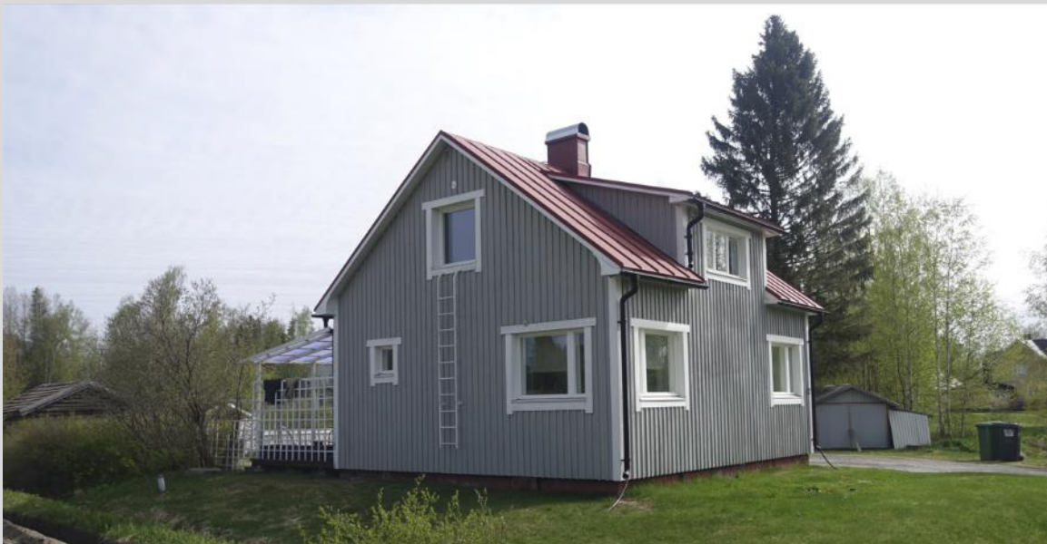
Bostadshus, fasad mot söder och väster.
