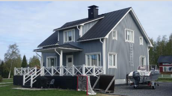
Bostadshus, fasad mot söder och öster.
