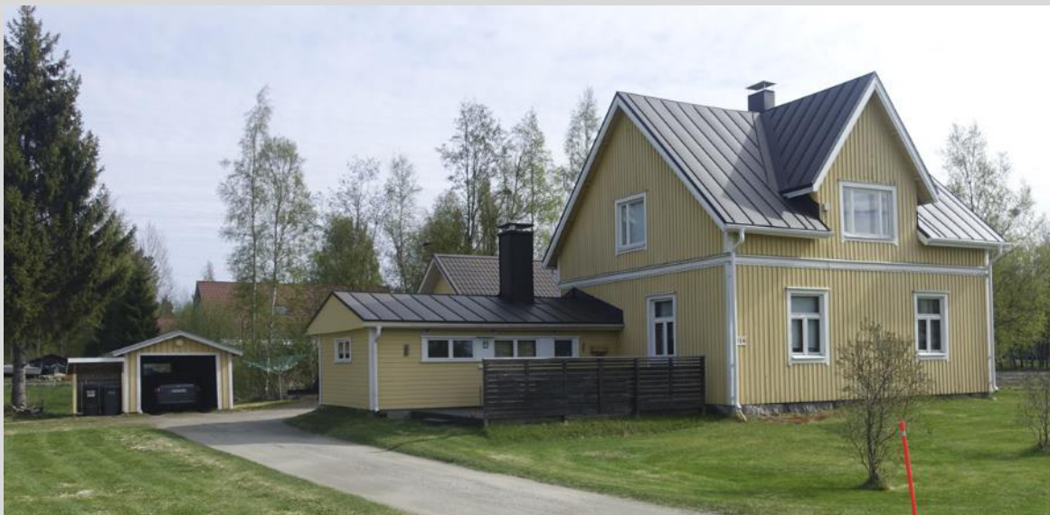
Bostadshus, fasad mot söder och väster.
