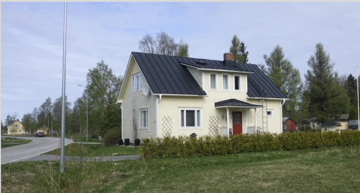
Bostadshus, fasad mot öster.
