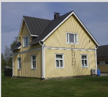
Fasader mot söder och öster.
