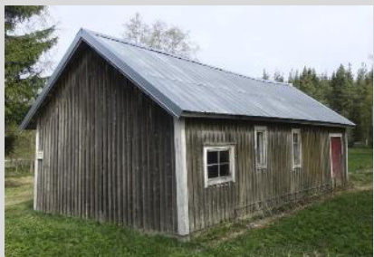
Uthus, fasader mot öster och söder.
