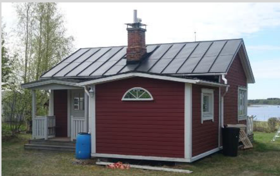
Fritidshus, fasad mot norr.
