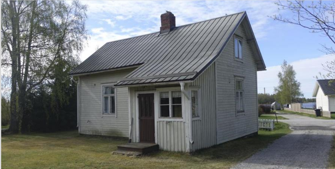
Asuinrakennus, pohjoinen julkisivu.
