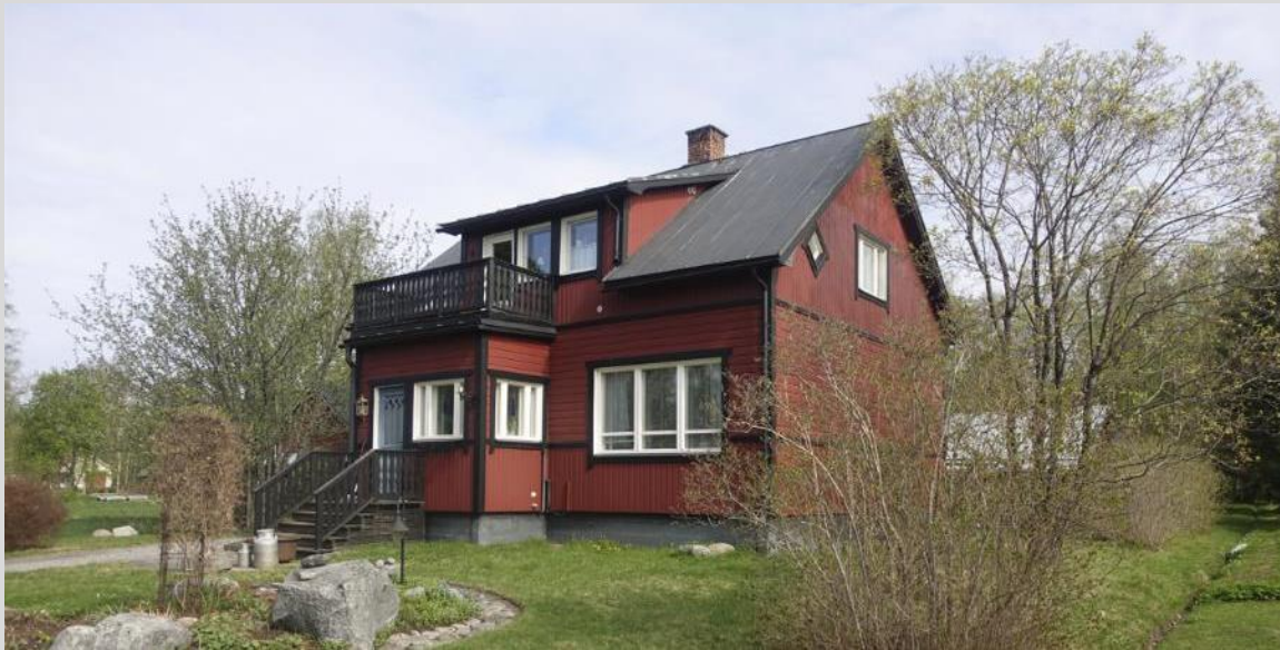
Asuinrakennus, julkisivu etelä-itä.
