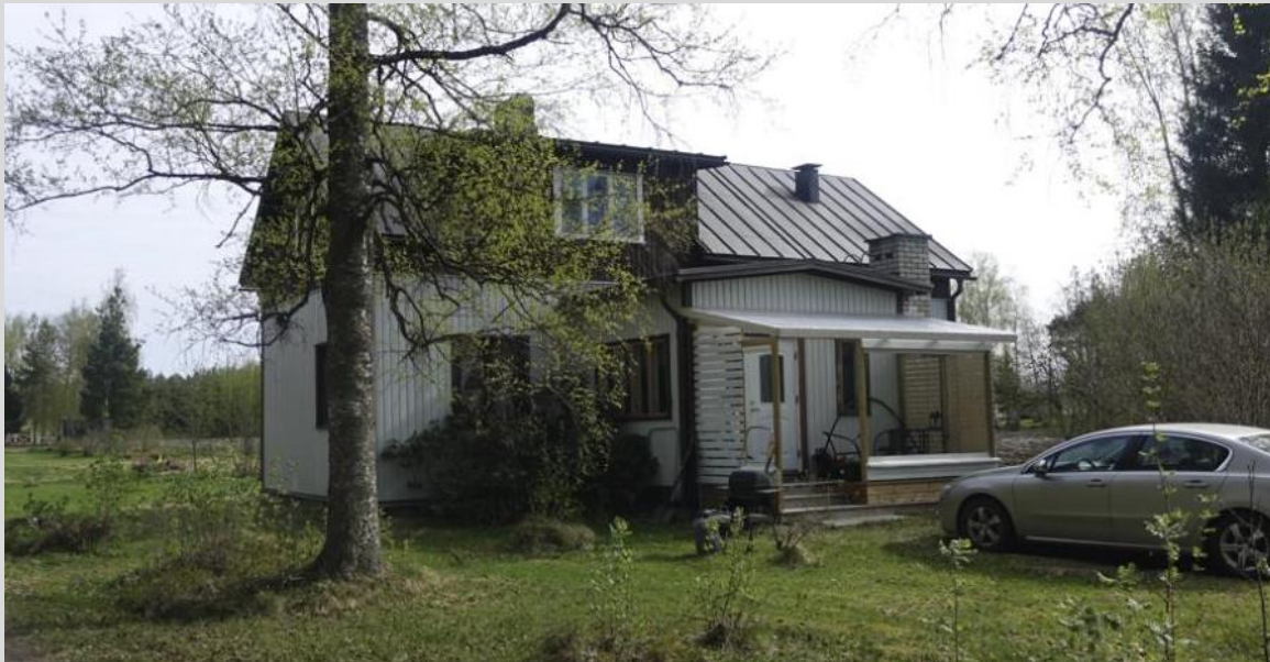
Asuinrakennus, eteläinen julkisivu.
