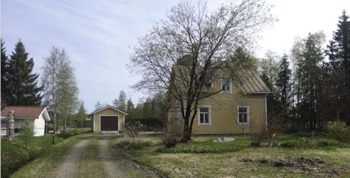
Asuinrakennus, eteläinen julkisivu.
