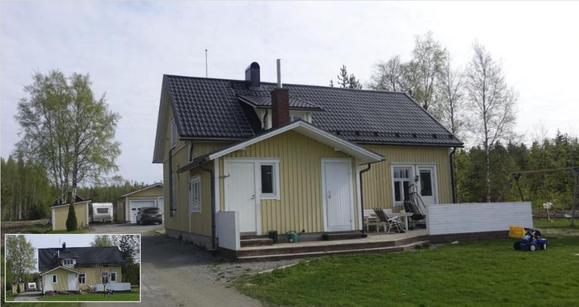
Asuinrakennus, eteläinen julkisivu.
