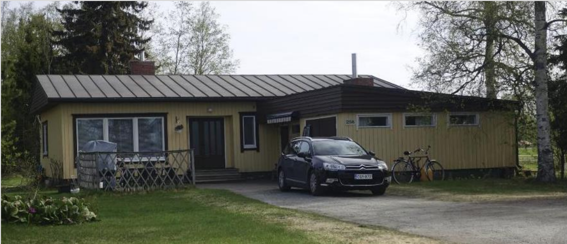
Asuinrakennus, eteläinen julkisivu.
