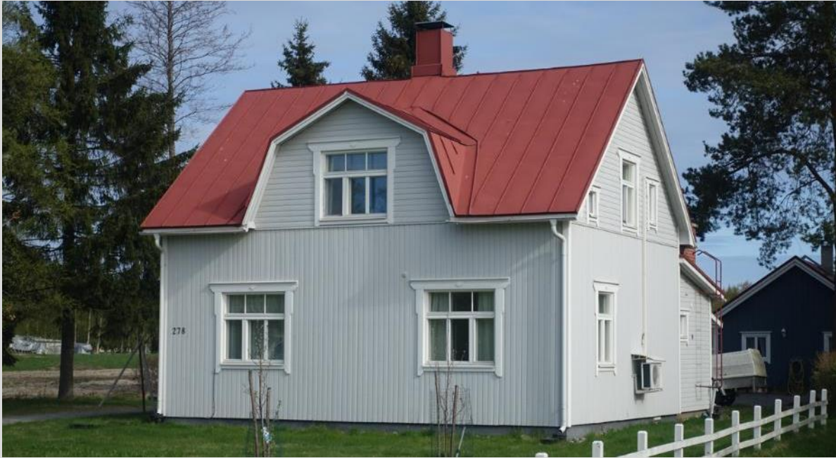
Asuinrakennus, julkisivut etelä-itä.
