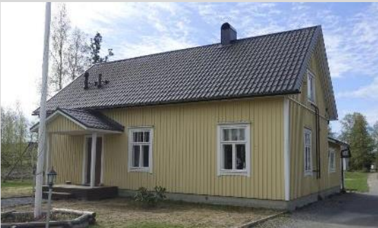
Asuinrakennus, pohjoinen julkisivu.
