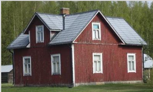
Asuinrakennus, julkisivu etelä-itä.
