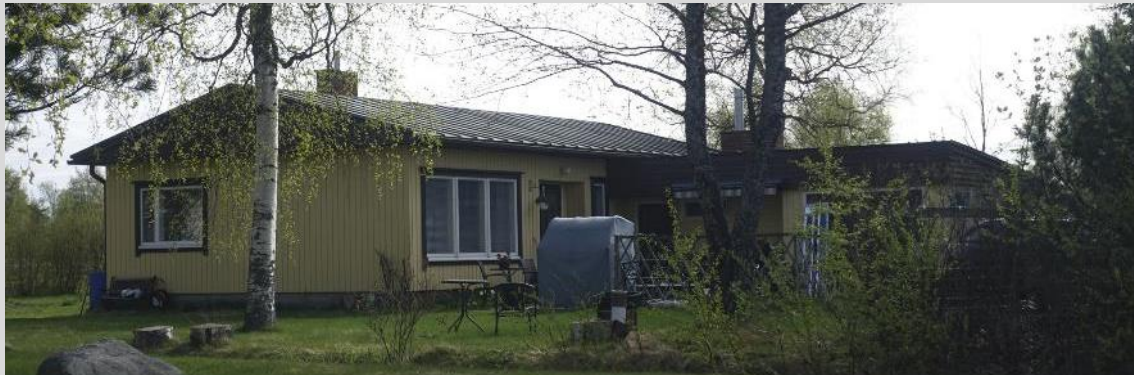
Asuinrakennus, länsi-etelä julkisivu.
