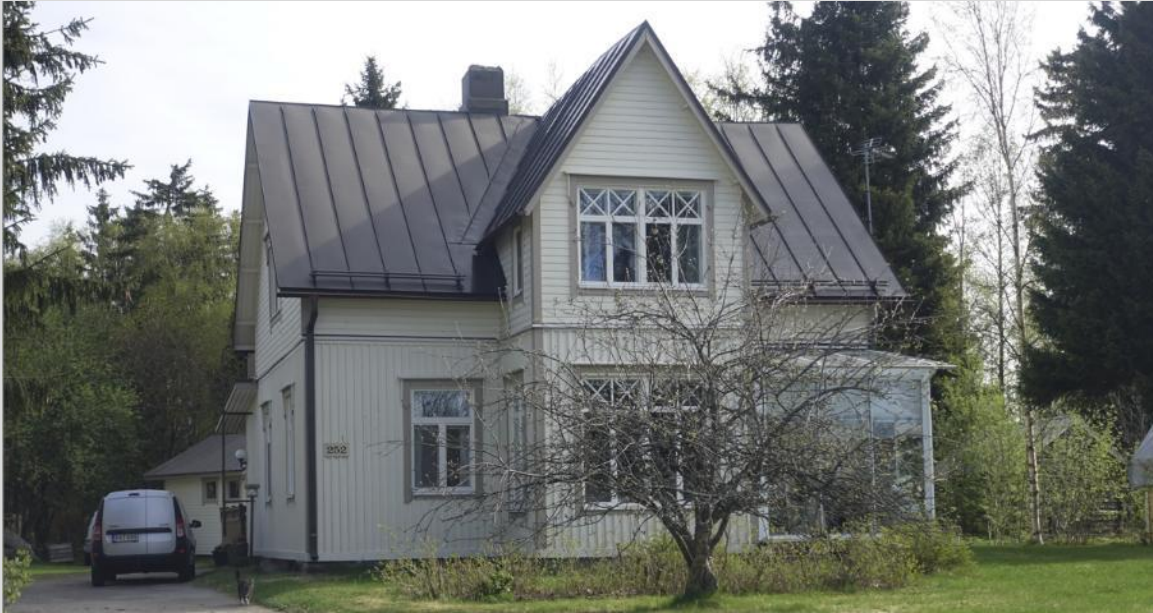
Asuinrakennus, eteläinen julkisivu.
