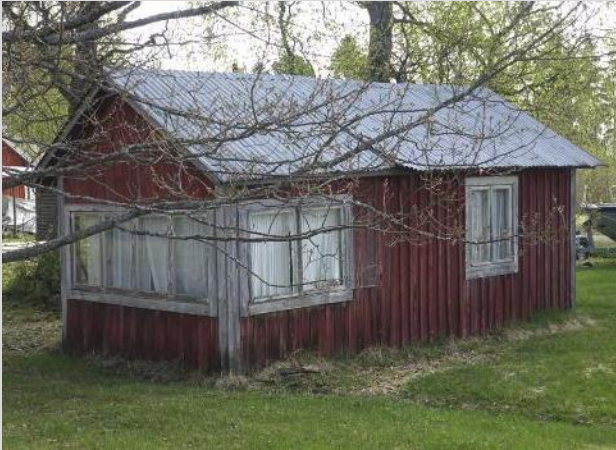
Ulkorakennus (1), julkisivut etelä-länsi.
