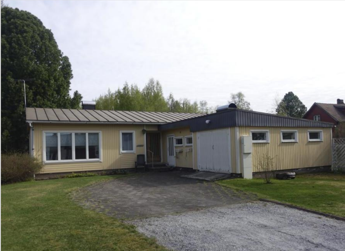
Asuinrakennus, eteläinen julkisivu.
