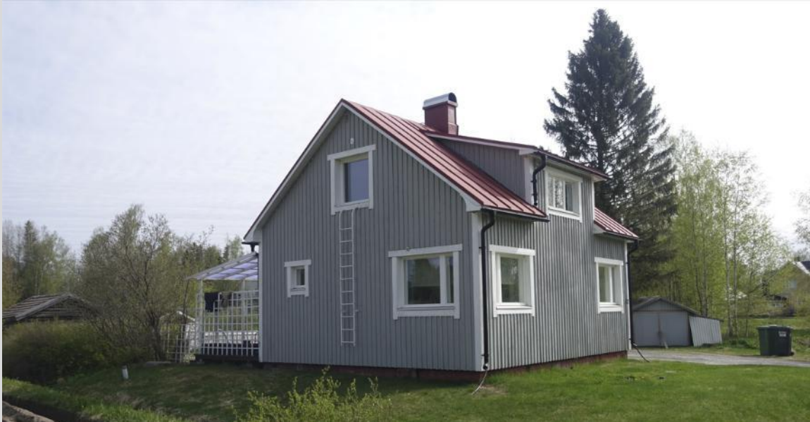
Asuinrakennus, etelä-länsi julkisivu.
