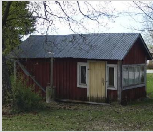
Ulkorakennus (1), julkisivut pohjoinen-länsi.
