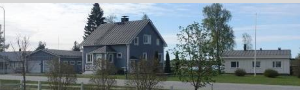
Asuinrakennus, eteläinen ja pohjoinen julkisivu.
