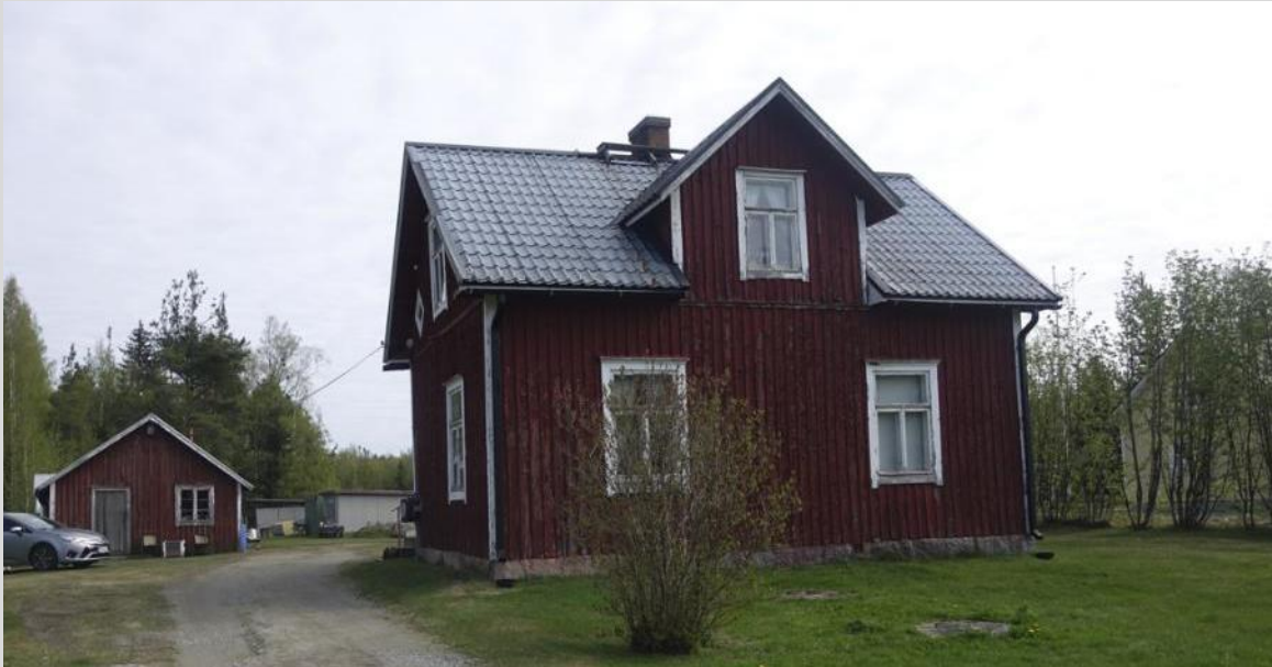
Asuinrakennus, eteläinen julkisivu.
