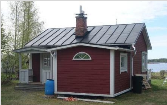
Vapaa-ajanrakennus pohjoinen julkisivu.
