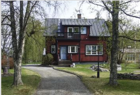
Asuinrakennus, julkisivu etelä.
